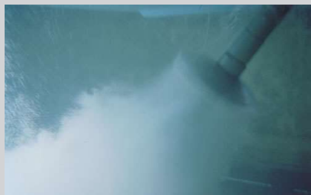
Foto submersa da hélice do Aerador em funcionamento.
